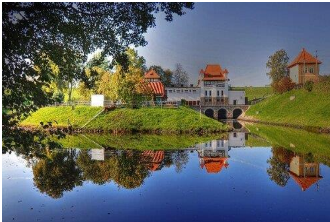
Elektrownia Wodna w Straszynie
