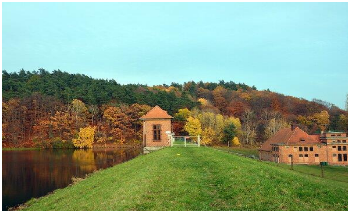
Elektrownia Wodna w Łapinie
