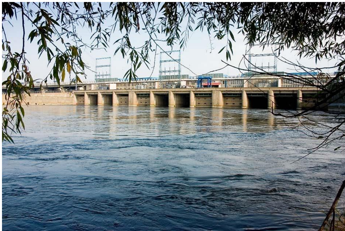
Elektrownia Wodna we Włocławku
