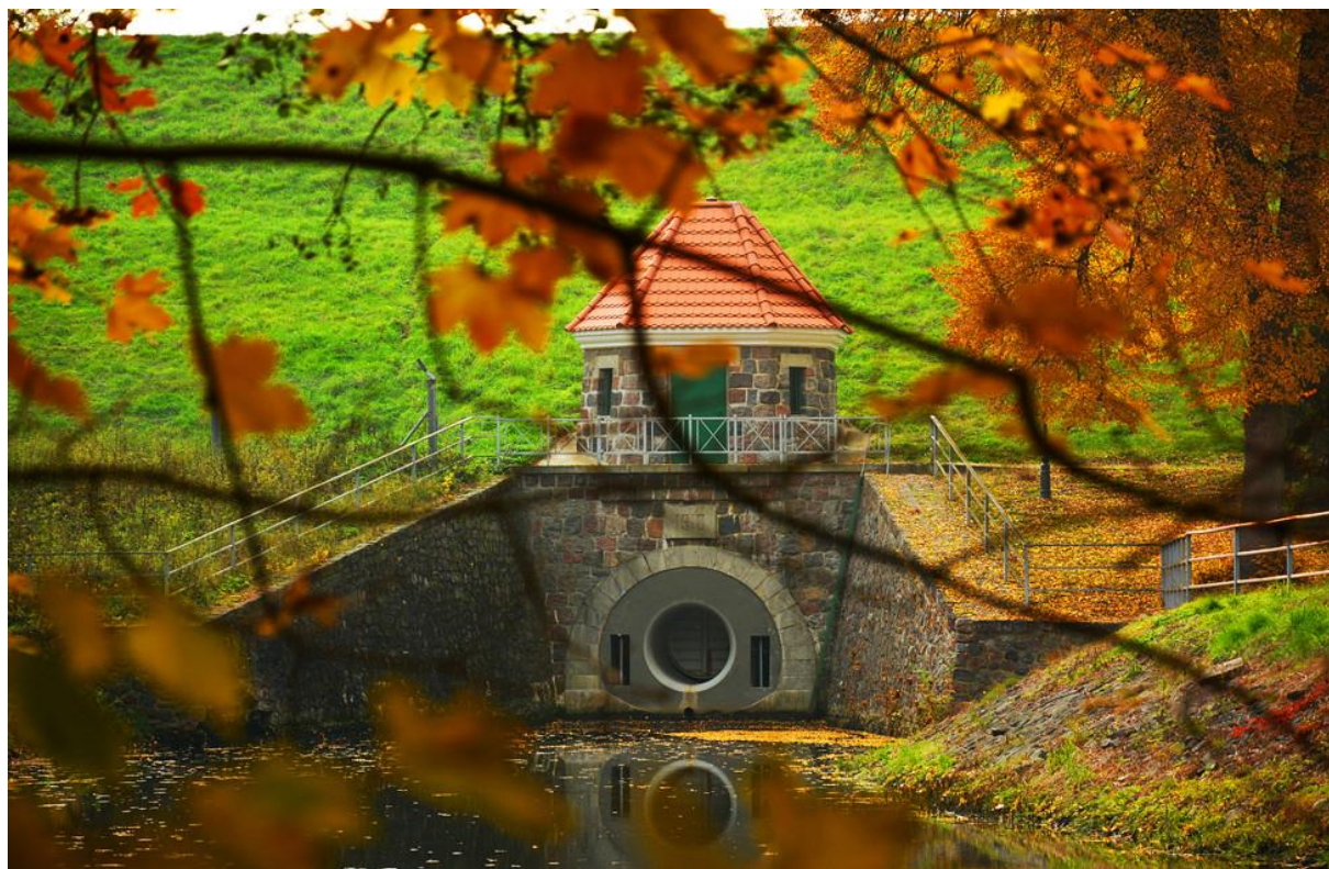
Elektrownia Wodna w Straszynie
