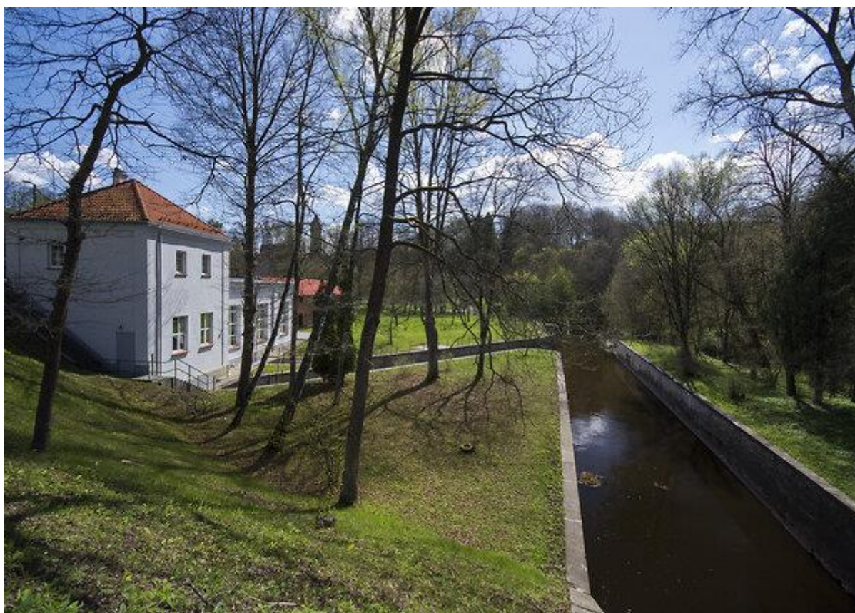
Elektrownia wodna Pieniężno
