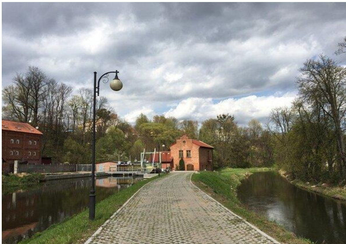
Elektrownia wodna Lidzbark
