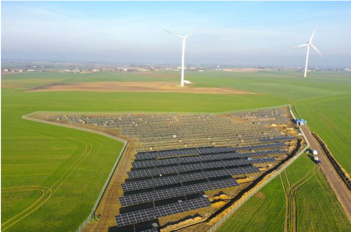
Młynów Szczepanki photovoltaic farm
