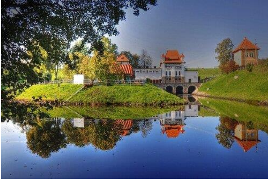
Elektrownia Wodna w Straszynie
