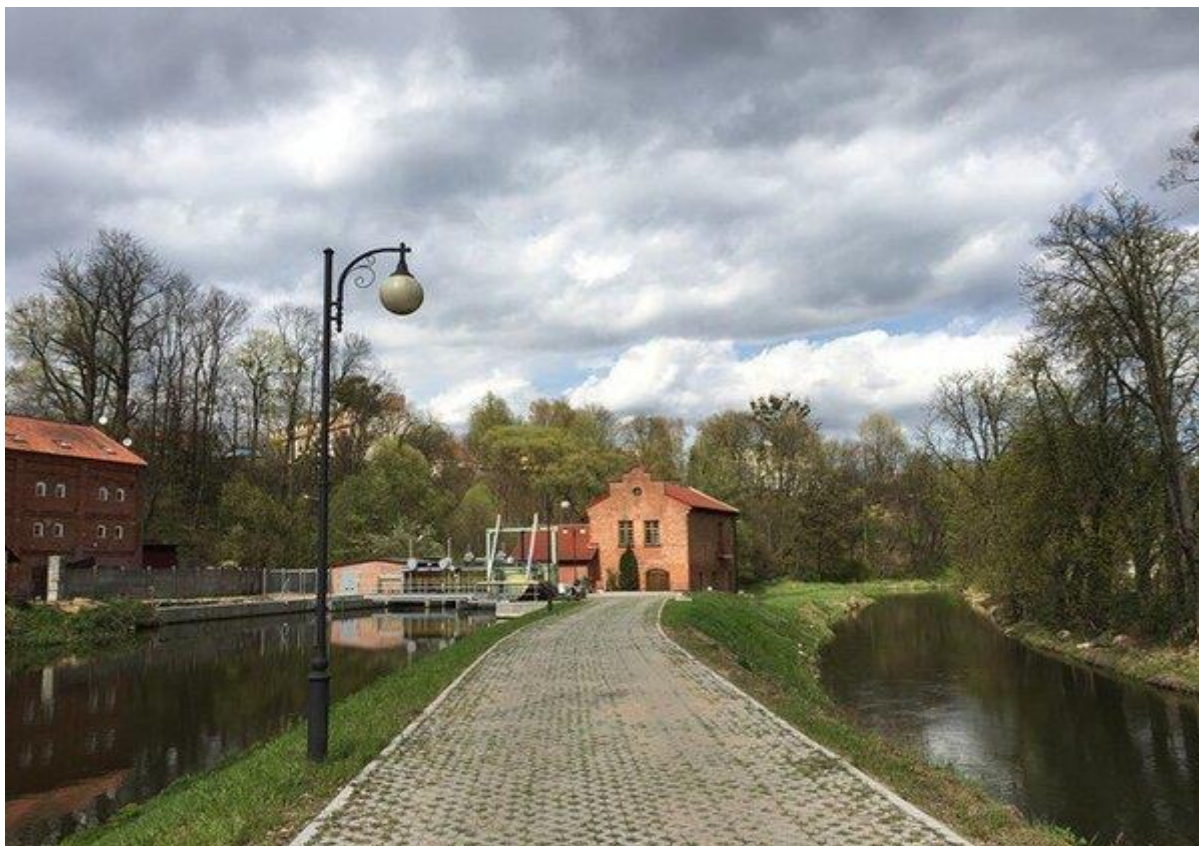
Elektrownia wodna Lidzbark
