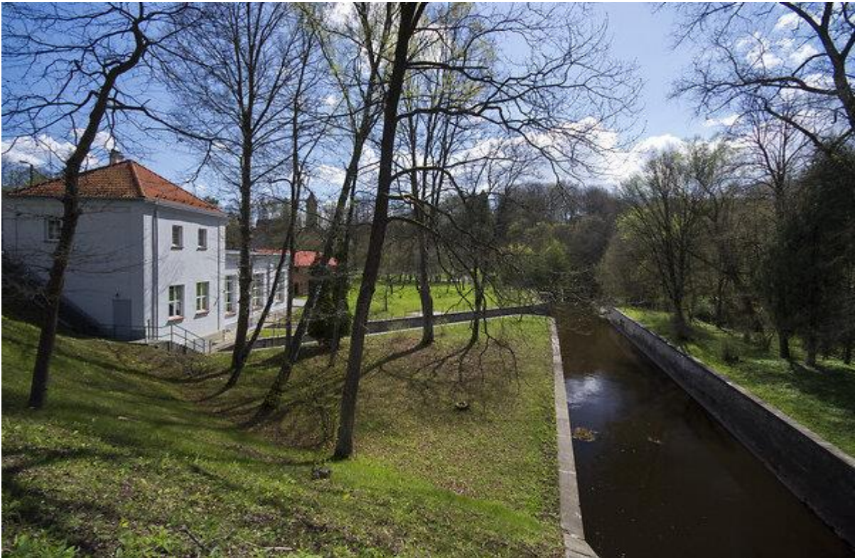
Elektrownia wodna Pięczęno
