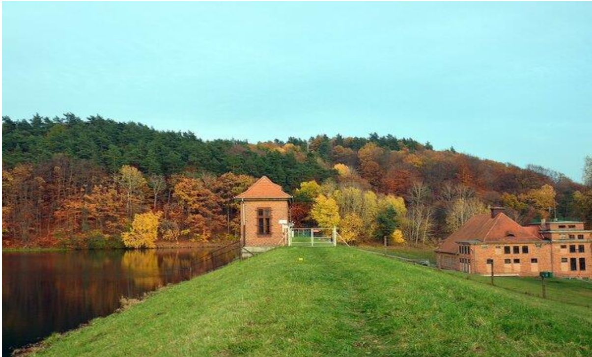
Łapino hydro plant
